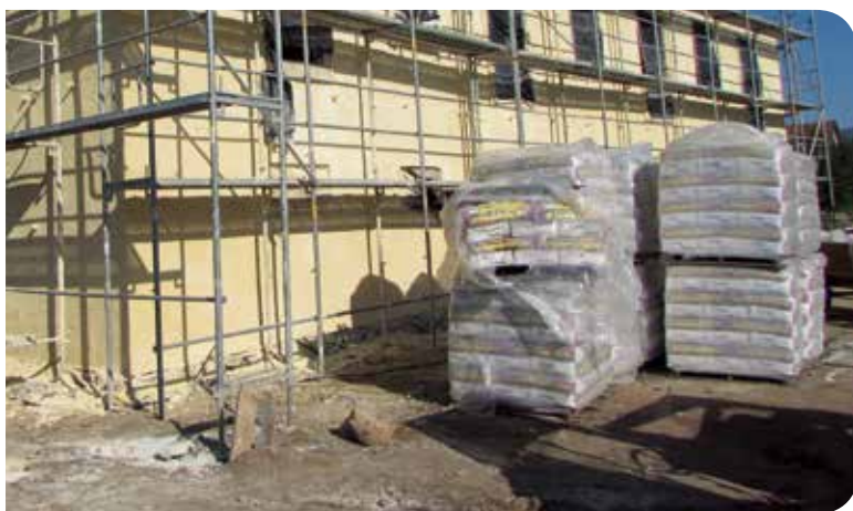
Fachada de construção em meio rural, renovada com melhoria de proteção térmica através da aplicação de reboco isolante webertherm aislone sobre alvenaria de pedra. (Arquiteto Alexandre Silva, Vale de Cambra)
